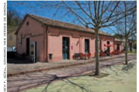
Antiga estació de Sant Feliu de Pallerols. Ruta del Carrilet.
