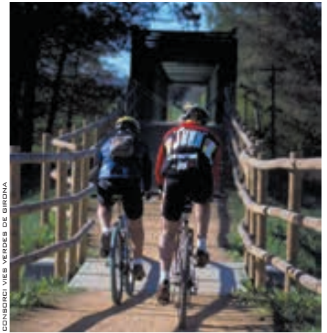
Pont sobre l'Onyar a la Via Verda del Carrilet.
